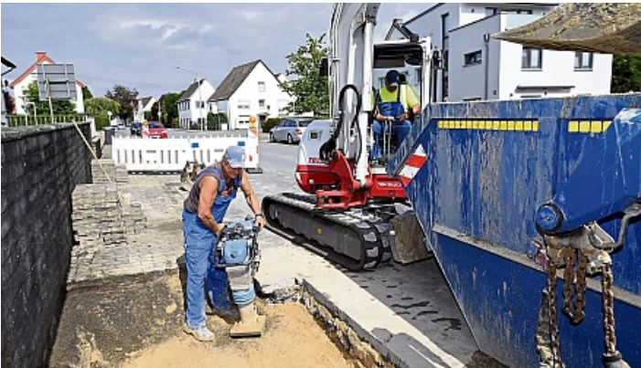
Der Gehweg musste wiederhergestellt werden.
